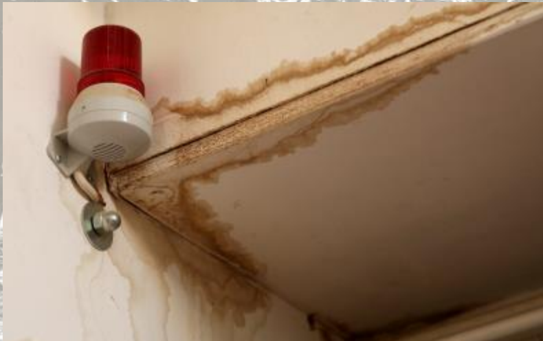
Undichtes Dach (Totalsanierung nötig)
