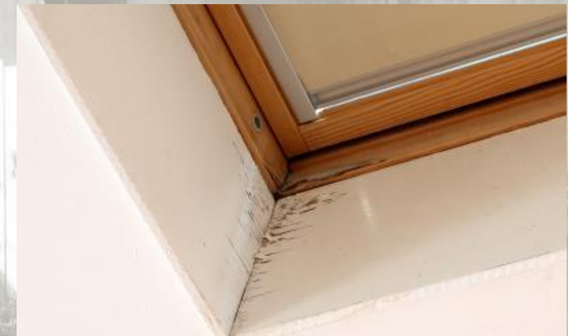
Undichte Dachfenster
