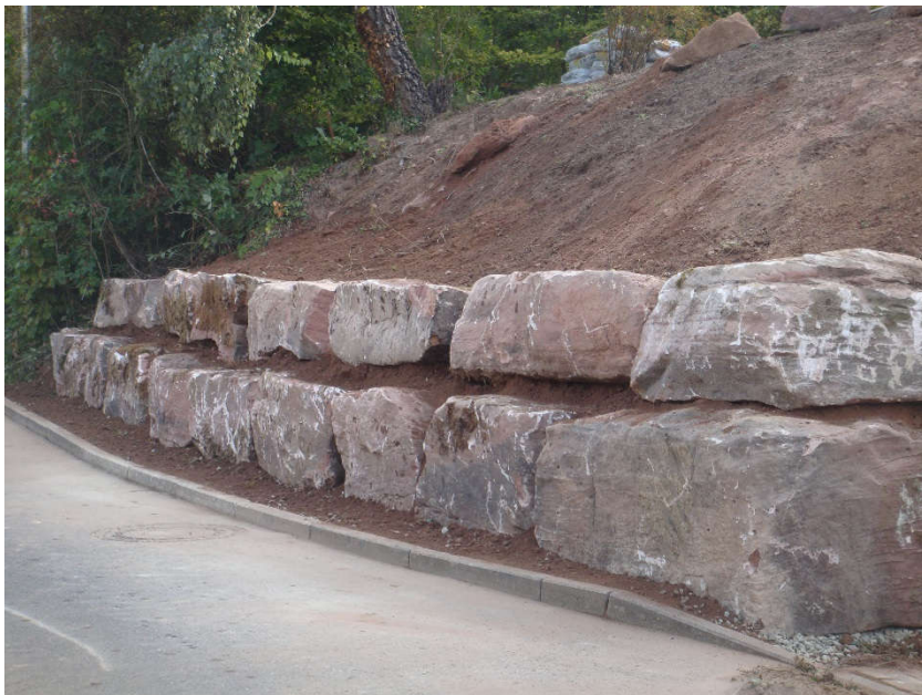
Abbildung 6: Hangsicherung mittels Steinen Beispielfoto
