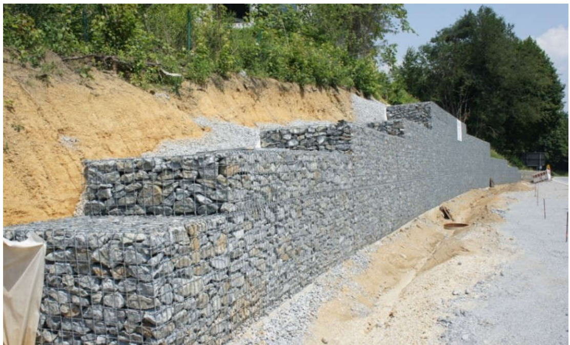
Abbildung 8: Hangsicherung mittels Gabionen Beispielfoto
